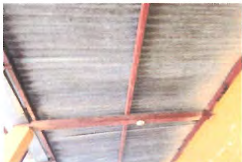
Foto1: ESTRUCTURA DE TECHO Sustitución de estructura metálica para soporte de cubierta de lámina incluyendo perfiles para vigas, travesaños, sujeta con tornillería; corte, soldadura y anclaje de la estructura portante. AULA 1, AULA 2 Y BAÑOS
