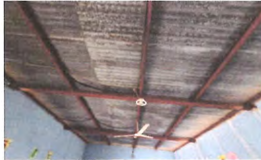
Foto 2:CUBIERTA DE LAMINA Sustitución de cubierta de techo con lámina galvanizada, Tipo de lamina: troquelada Calibre: 26, incluye: fijaciones y sellado en traslapes. AULA 1, AULA 2 Y BAÑOS
