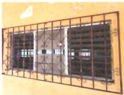
Foto 5: VENTANAS Reparación de balcones metálicos, incluyendo fijaciones, pintura y soldaduras. AULA 1
