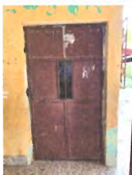
Foto 3: PUERTAS Suministro e instalación de puerta metálica, incluyendo chapa, bisagras. Aula 1 y aula 2
